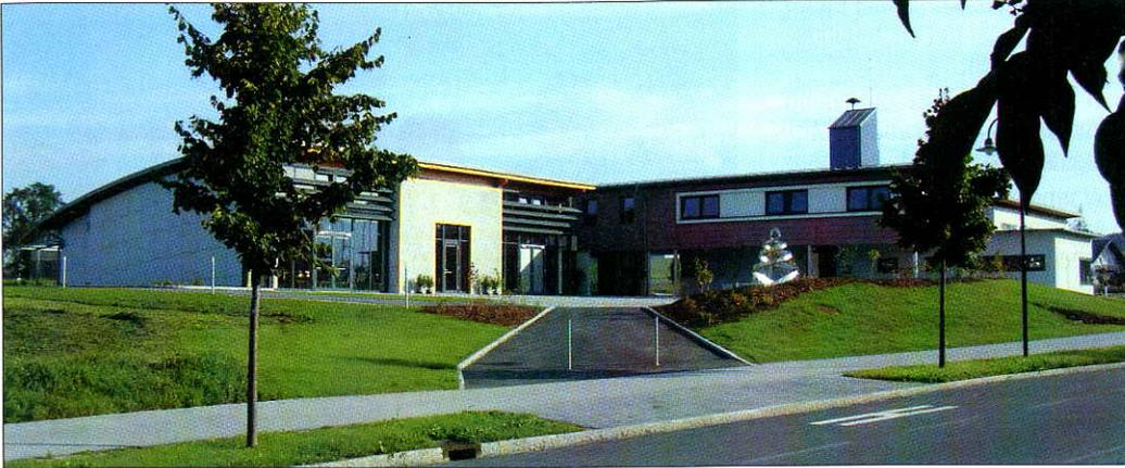
Auf den ersten Blick eine moderne Stahl- und Glaskonstruktion, schafft das Bauwerk den Spagat zur ökologischen Bauweise. Als Hauptbaustoff wurde heimisches Holz verwendet, und die Verwendung dieses nachwachsenden Rohstoffs wurde konsequent durchgezogen bis zur Beheizung der gesamten Anlage durch eine Hackschnitzel-Heizanlage.
