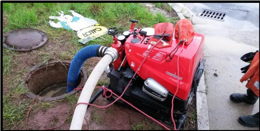
*Bild 10 Auspumpen mittels Tragkraftspritze*
