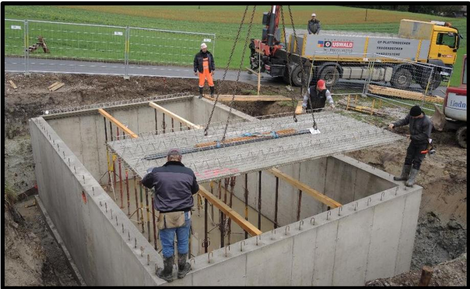
Bild 50 Verlegen der Großformatdecke
